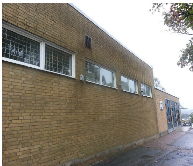
Figur 2. Fotot visar östrabyggnadens fasad mot väst, fotot taget mot syd
